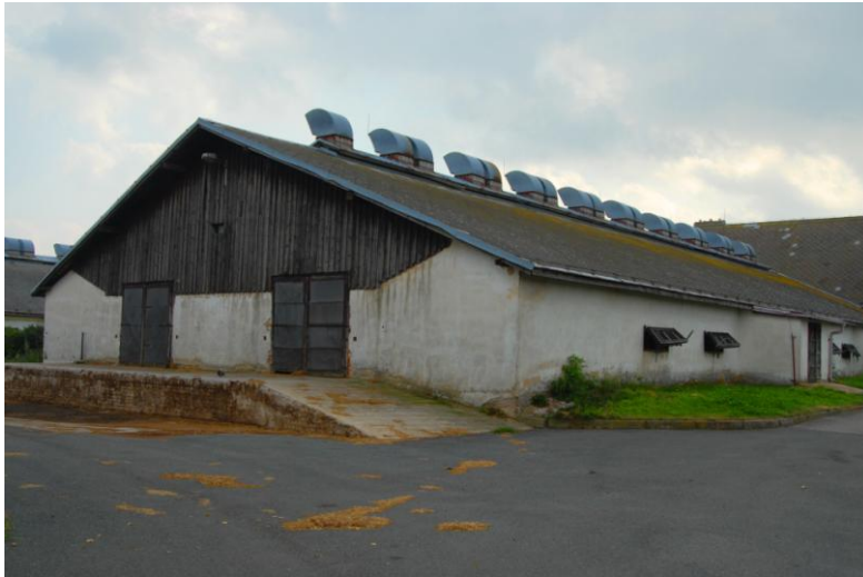
Obr. 1 Skutečná vnější a vnitřní dispozice haly v Červeném Újezdě. Za pozornost stojí průduchy ve stropě drůbežárny, které jsou opatřeny posuvnými zástěnami, jimiž v praxi obsluha reguluje intenzitu odvodu vzduchu z prostoru.
