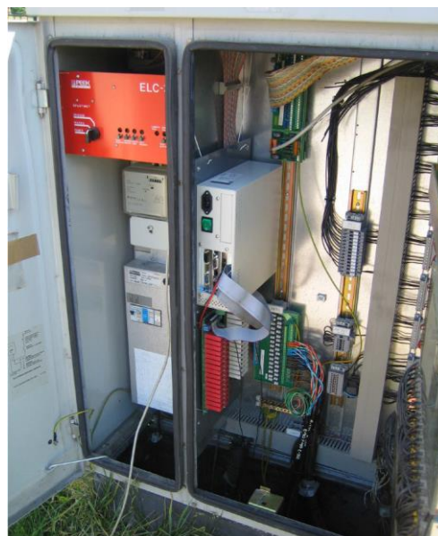
Obr. 22. Prototyp fuzzy regulátoru FUSICO (vlevo) [33], instalace FUSICO systému řízení (vpravo) [34]
