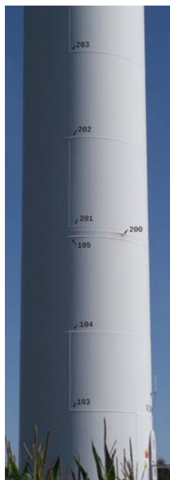
Obr. 4 Spoje sekcí a prstenců -část 1
