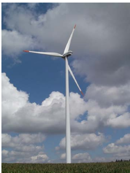
Obr. 1: Větrná elektrárna u obce Kámen
