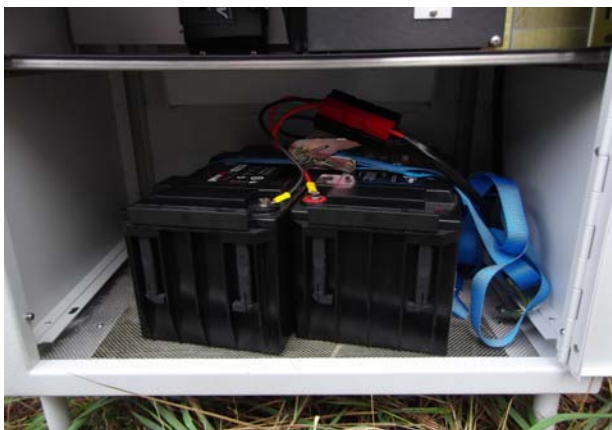
Obr. 12: Zapojení baterií
