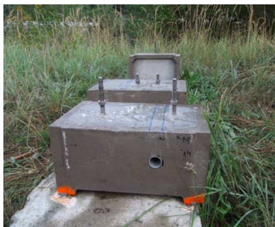
Obr. 3: Zalepené kotevní prvky
