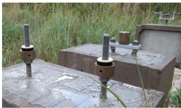
Obr. 5: Závitnice s podložkami
