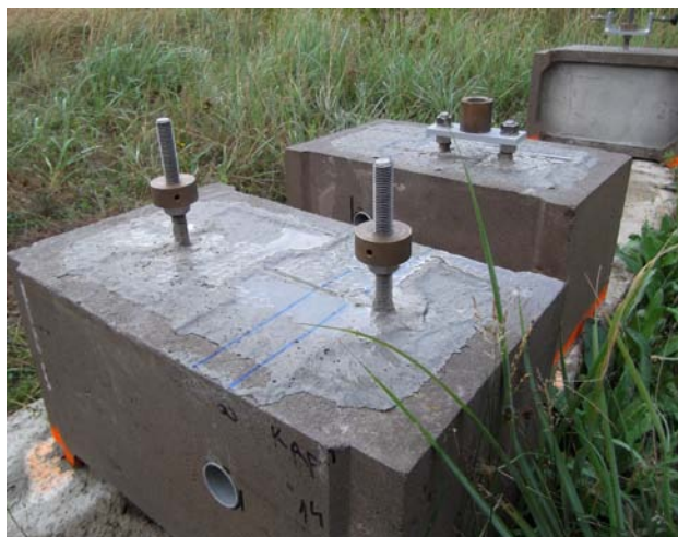
Obr. 4: Osazené základnové matky
